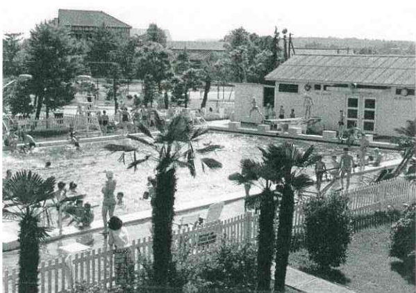
基地内のプール
